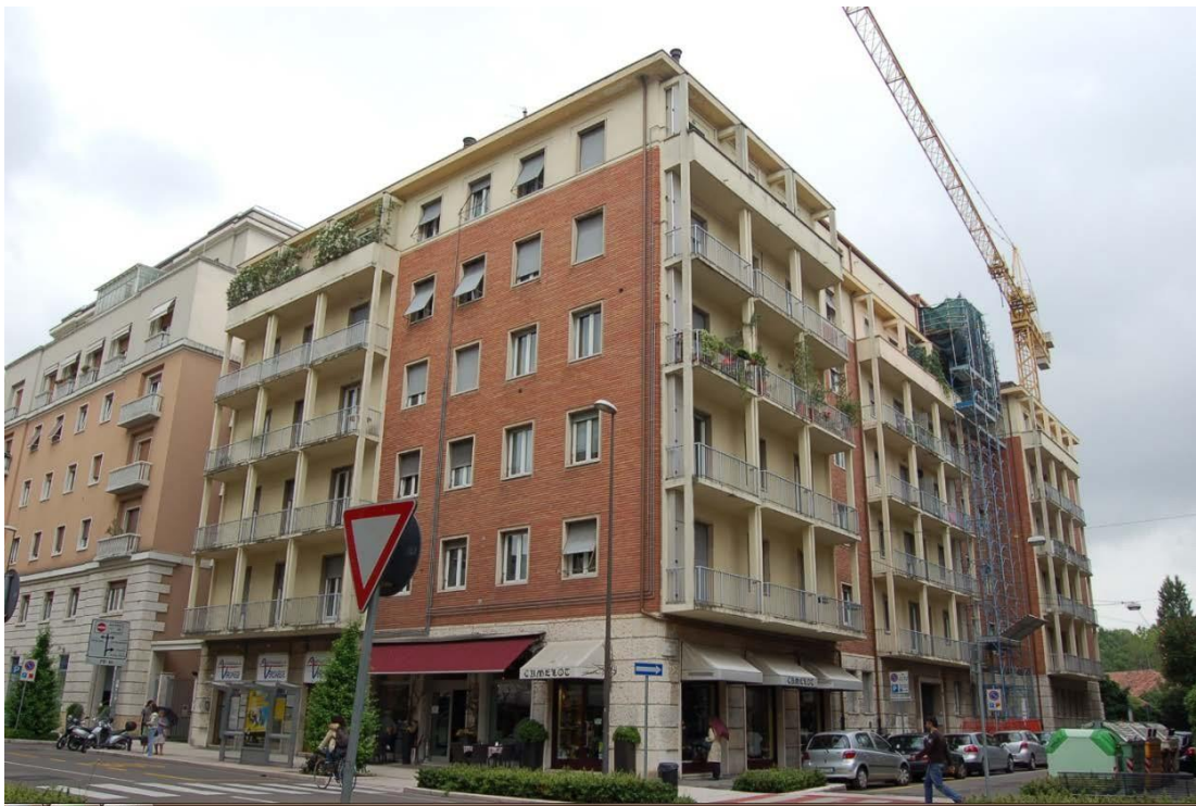
FOTO 1: particolare condominio prospiciente su Via Isonzo e Via IV Novembre
