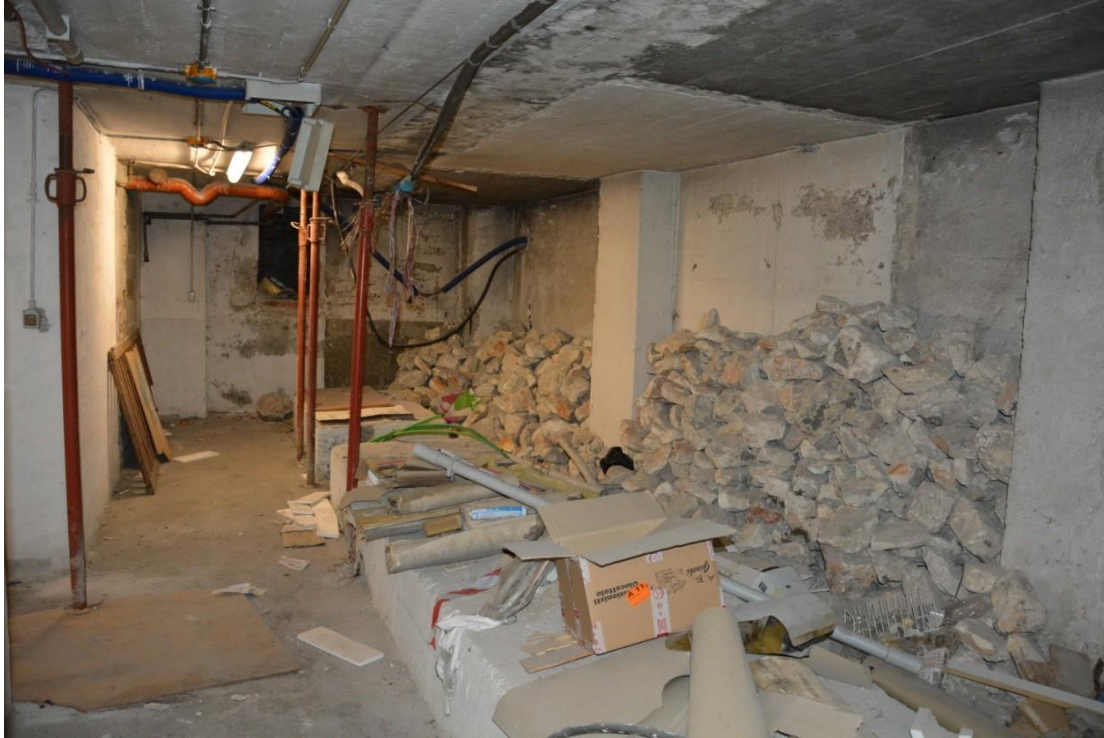
FOTO 3: particolare delle pareti divisorie demolite e dei due dadi di fondazione
