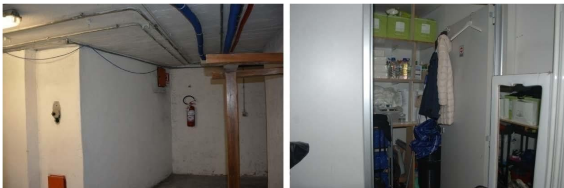
FOTO 7: porzione di corridoio comune, al piano interrato, in cui ricade il sub 245 e del ripostiglio posto all'interno del negozio al piano terra, identificato catastalmente col sub 232, in cui ricade il sub 210
