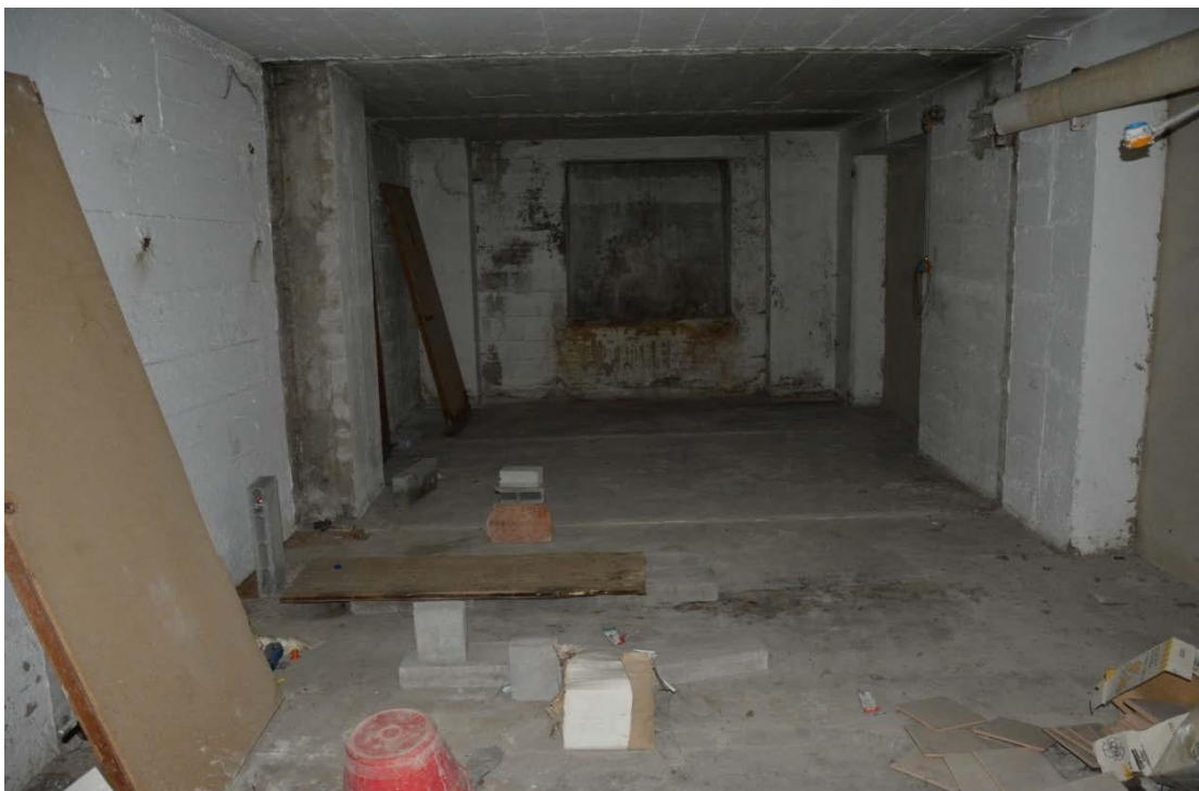
FOTO 4: particolare delle pareti divisorie demolite e delle tamponature delle porte
