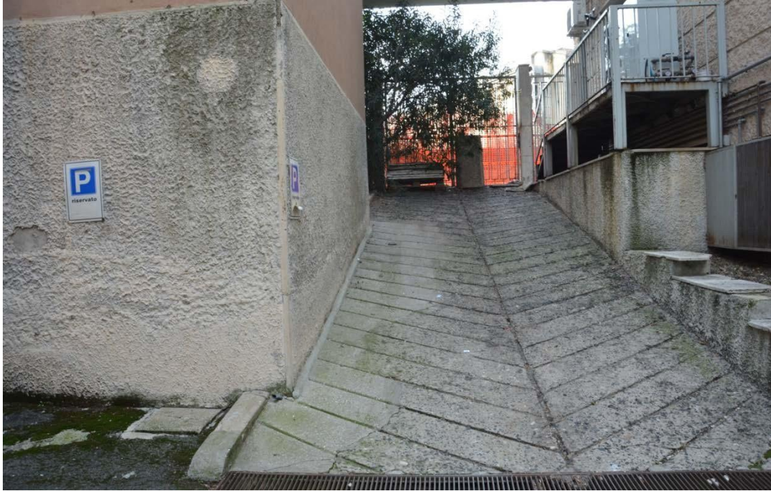
FOTO 11: particolare rampa di accesso da Viale della Repubblica
