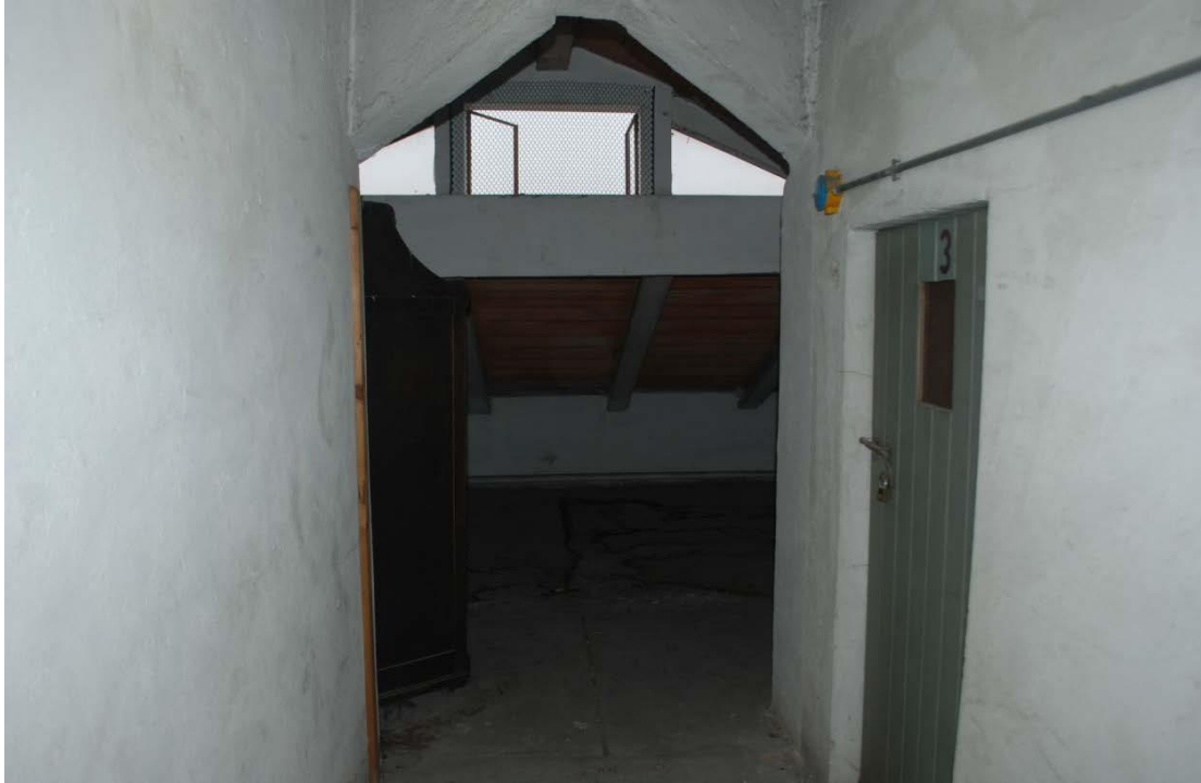
FOTO 14: particolare degli accessi alle soffitte del sottotetto
