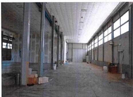
Il confinamento interno del manto in fibrocemento
