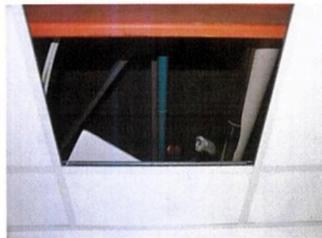
Il confinamento interno del manto in fibrocemento
