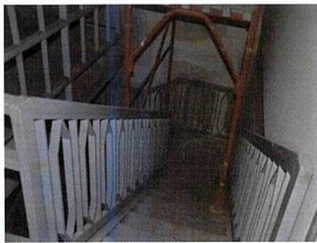
La scala in prossimità del soppalco
