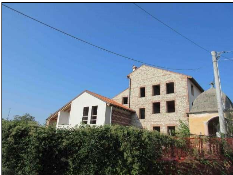
foto esterna lato nord-est
