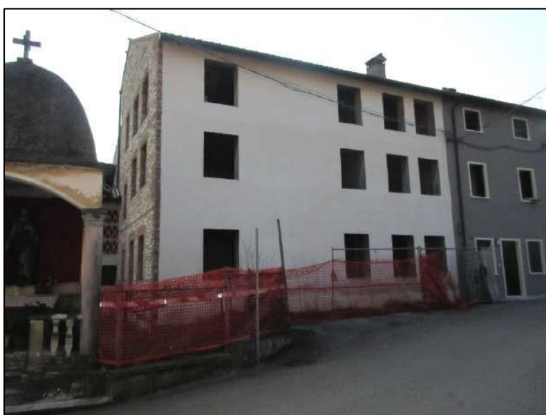
foto esterna lato nord
