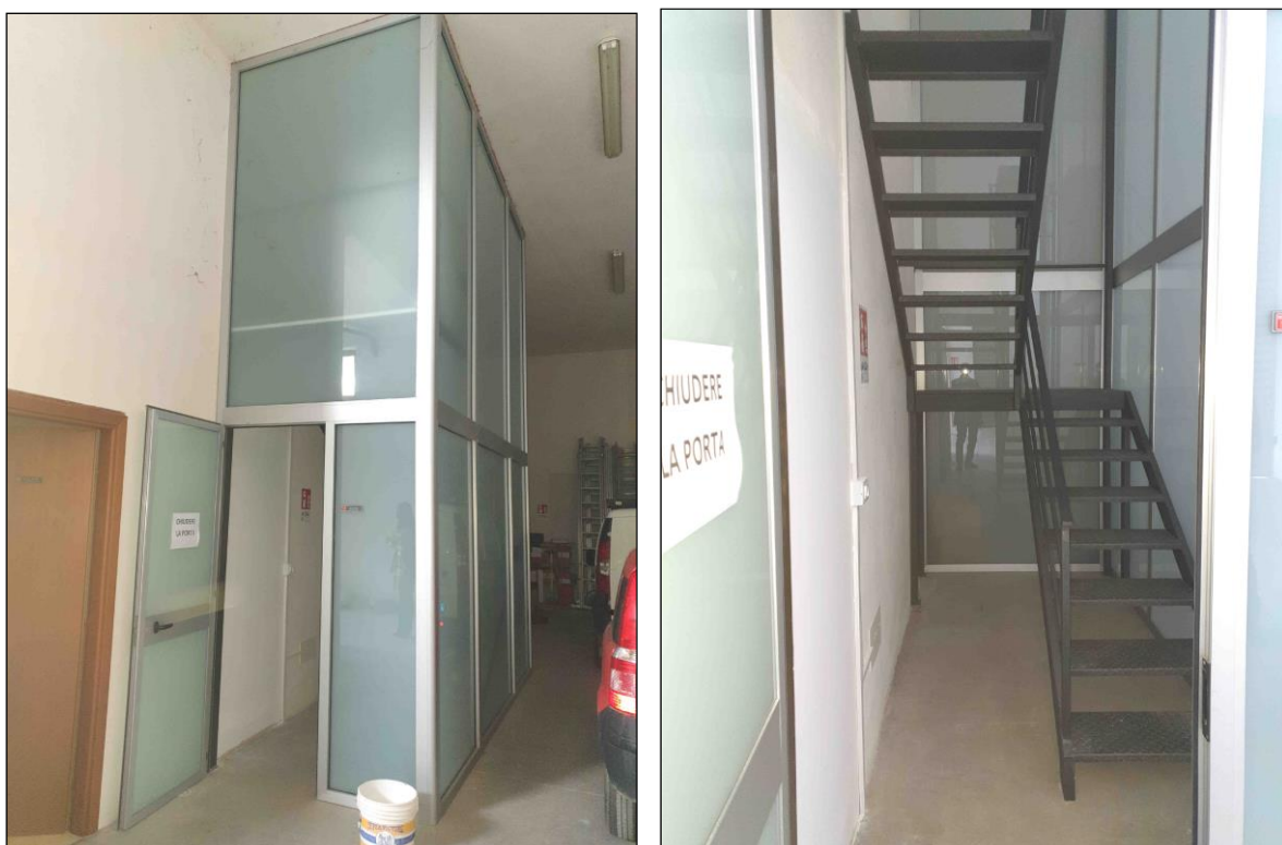
vano scala che conduce all'ammezzato
