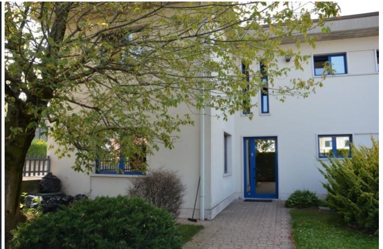
area davanti la palazzina uffici
