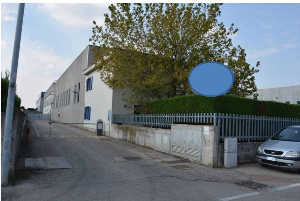
m.n. 488 accesso carraio al fabbricato affiancato ad ovest
