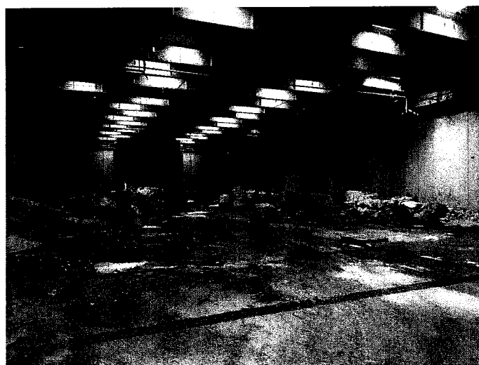
Figura 21. Corpo di Fabbrica D. Locale confinante con il fabbricato del mapp. 940.
