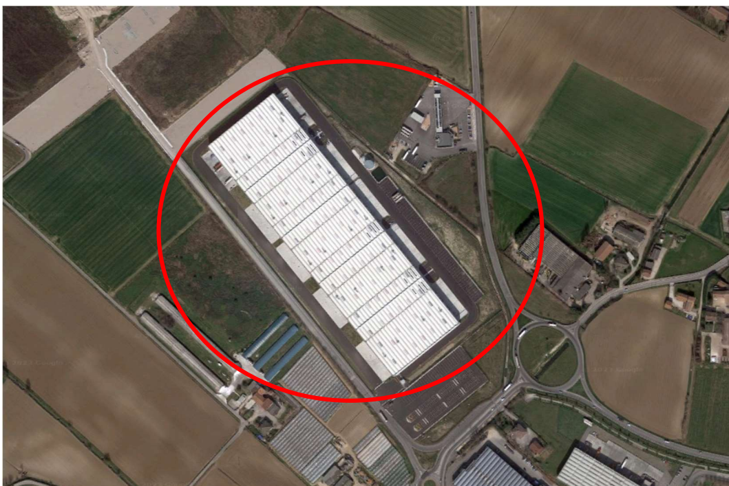
Figura 1: aerofotogrammetria con indicato il fabbricato nel quale è installata la scaffalatura oggetto di valutazione
