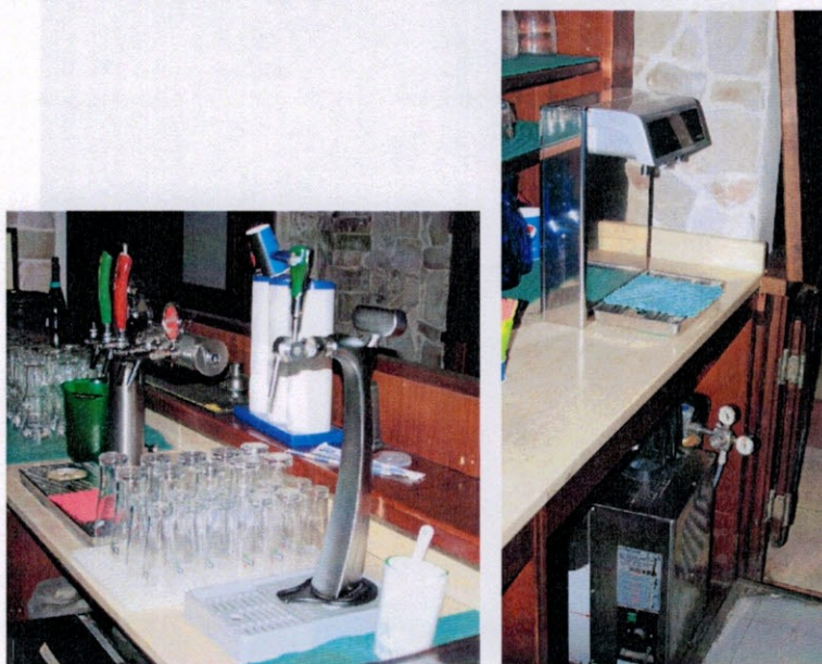
FOTO 5,6,7,8,9 FRIGORIFERI SOTTO-BANCO; LAVASTOVIGLIE; MACCHINA PROFESSIONALE CAFFE' ESPRESSO, MACINADOSATORE, DISPENSER PER ORZO E GINSENG; SPILLATORE; GASATORE/REFRIGERATORE
