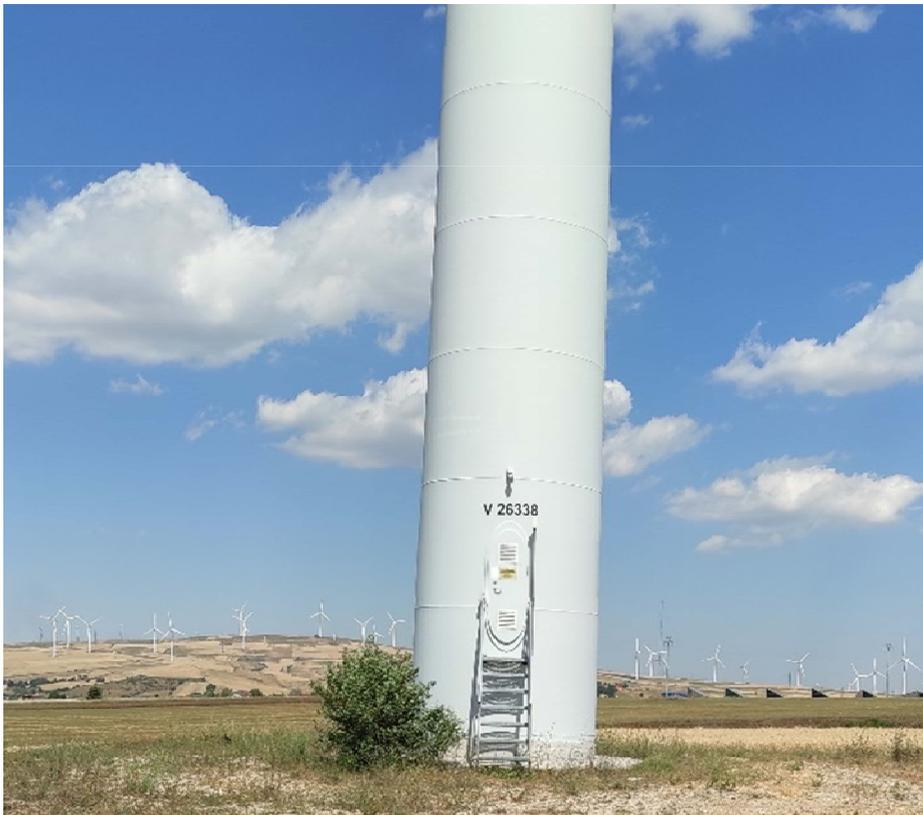
**Figura 5 - Base Turbina VESTAS V52- 850 kW (matricola n. 26338)**
