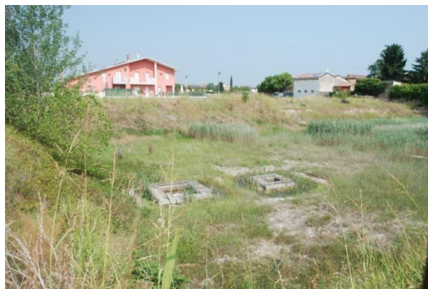
scavo di sbancamento e plinti
