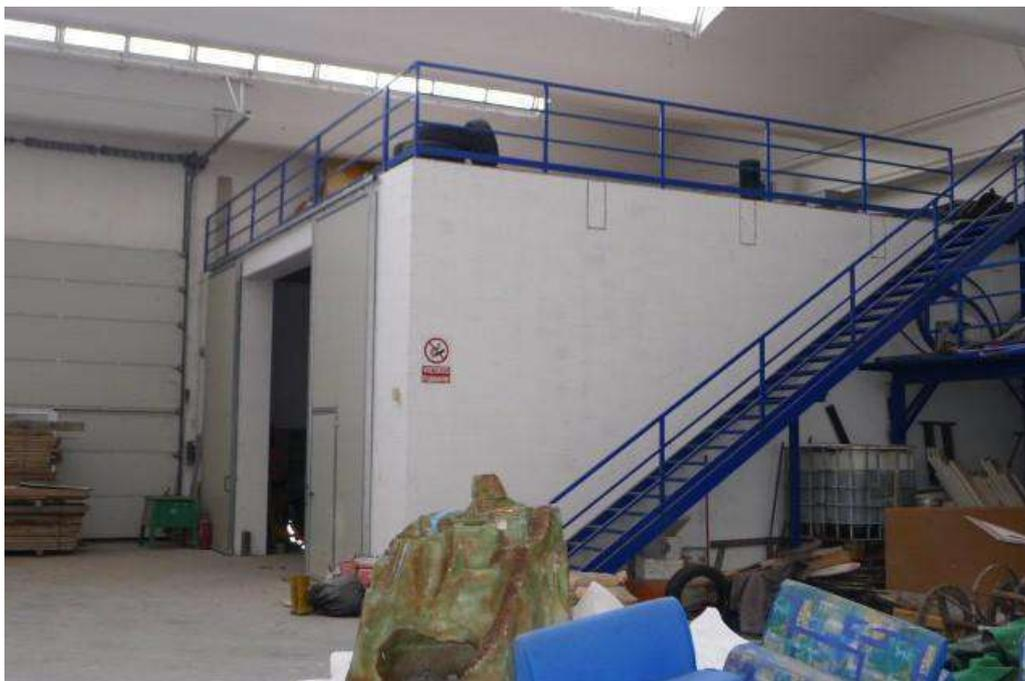
L'officina è realizzata in muratura con solaio di copertura in legno, con travi lamellari ed assito sovrastante; chiusura con portone scorrevole a due ante.
