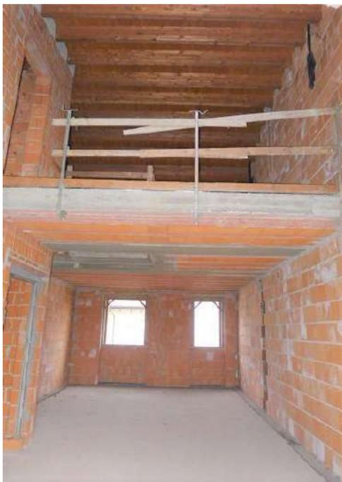
La struttura del tetto è in latero-cemento nelle due ali laterali ed in legno a vista nel corpo centrale, ove sono ricavati due soppalchi a giorno.
