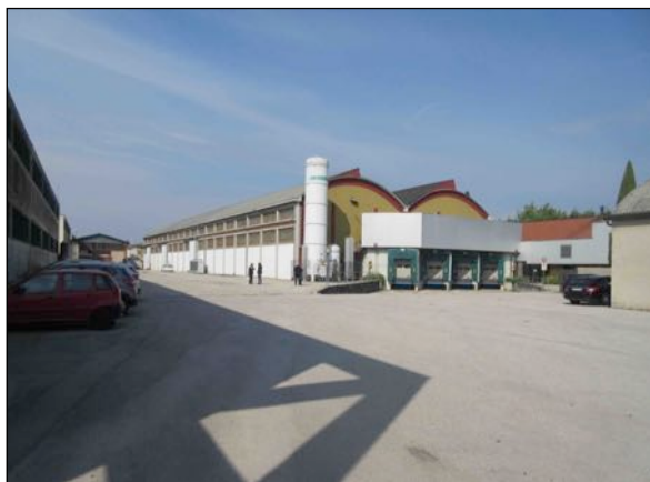
ingresso lato est
