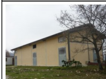
#2: Strutture Agricole - Valfabbrica (PG)
