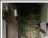
#48: N. 2 Aspiratori e Pompa Acqua
