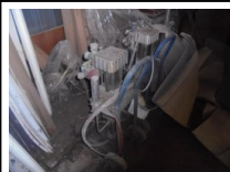
#75: N. 4 Pompe Aspirazione Verniciatura
