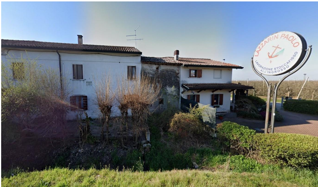
Unità immobiliari viste da nord : freccia sx Abitazione ; freccia dx Uffici
