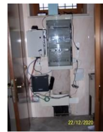
Vano p. terra
