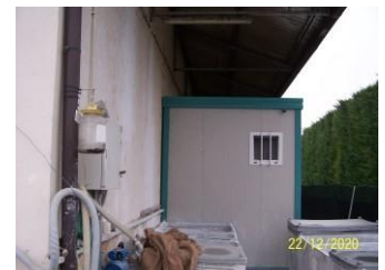
Spogliatoi lato est
