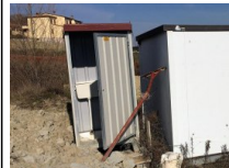
#39: Bagno da Cantiere
